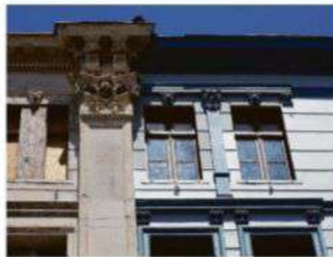
BALCONES, FIGURAS Y VENTANAS YA ESTÁN SIENDO INTERVENIDAS.
