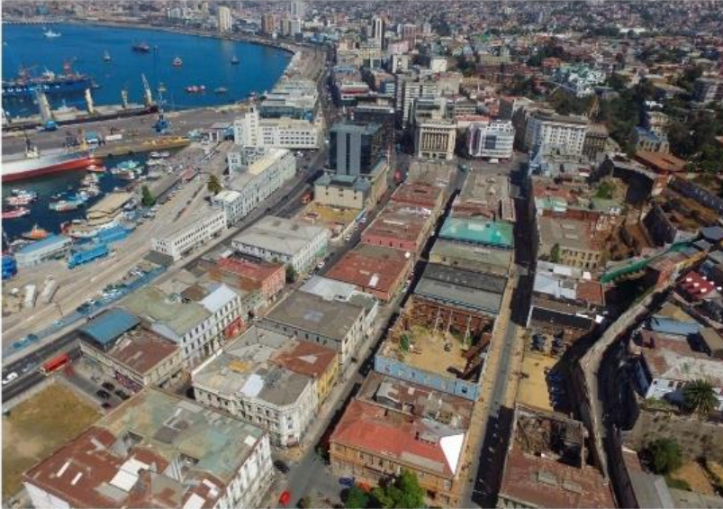
ELEMENTOS CONSTRUIDOS: Principal configurador del paisaje de la Zona Típica
