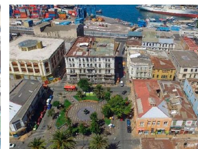
Frentes totalmente contruidos y de altura unitaria
