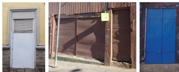
Puertas de inmuebles sin valor o discordantes
