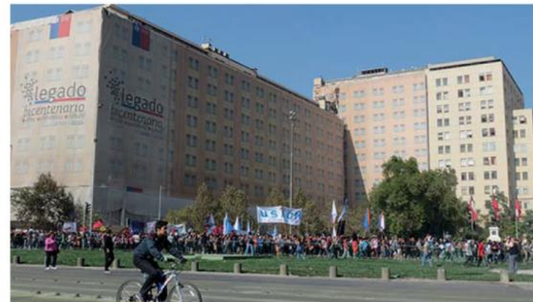
Malla protectora en inmueble en proceso de restauración.
